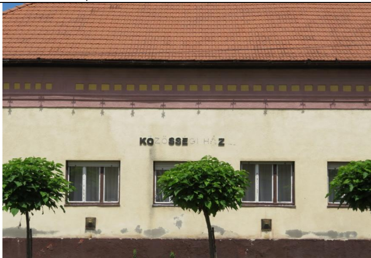
Közösségi ház, 2017 júliusi állapot, rekonstrukciója megkezdődött
