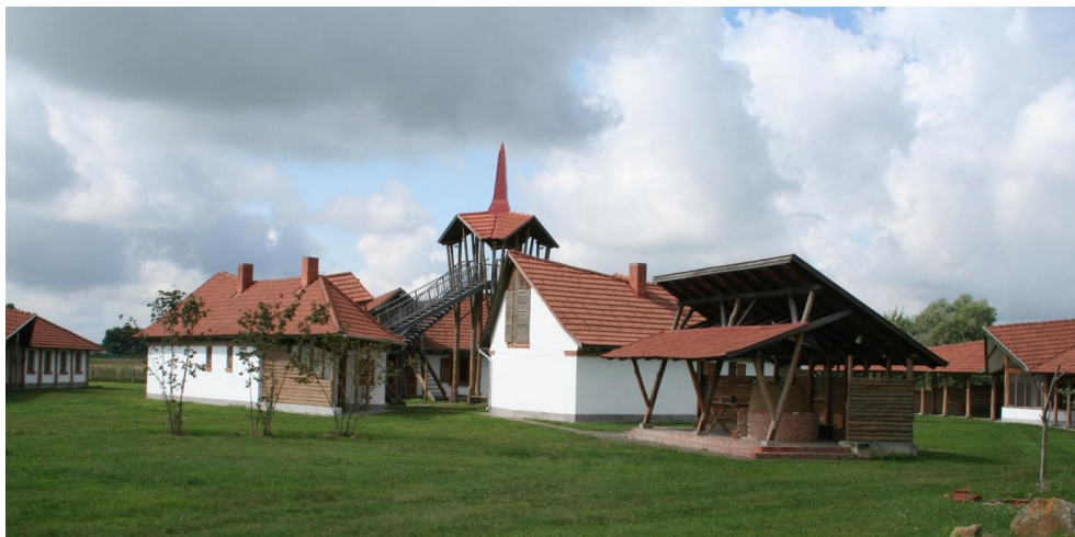
Az épületek kialakítása helyben kitermelt anyagokból, 3 féle földanyagú építési technikával történ.
