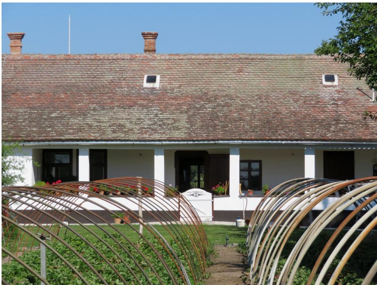
A falusi lakóház Jókai utcai homlokzata
