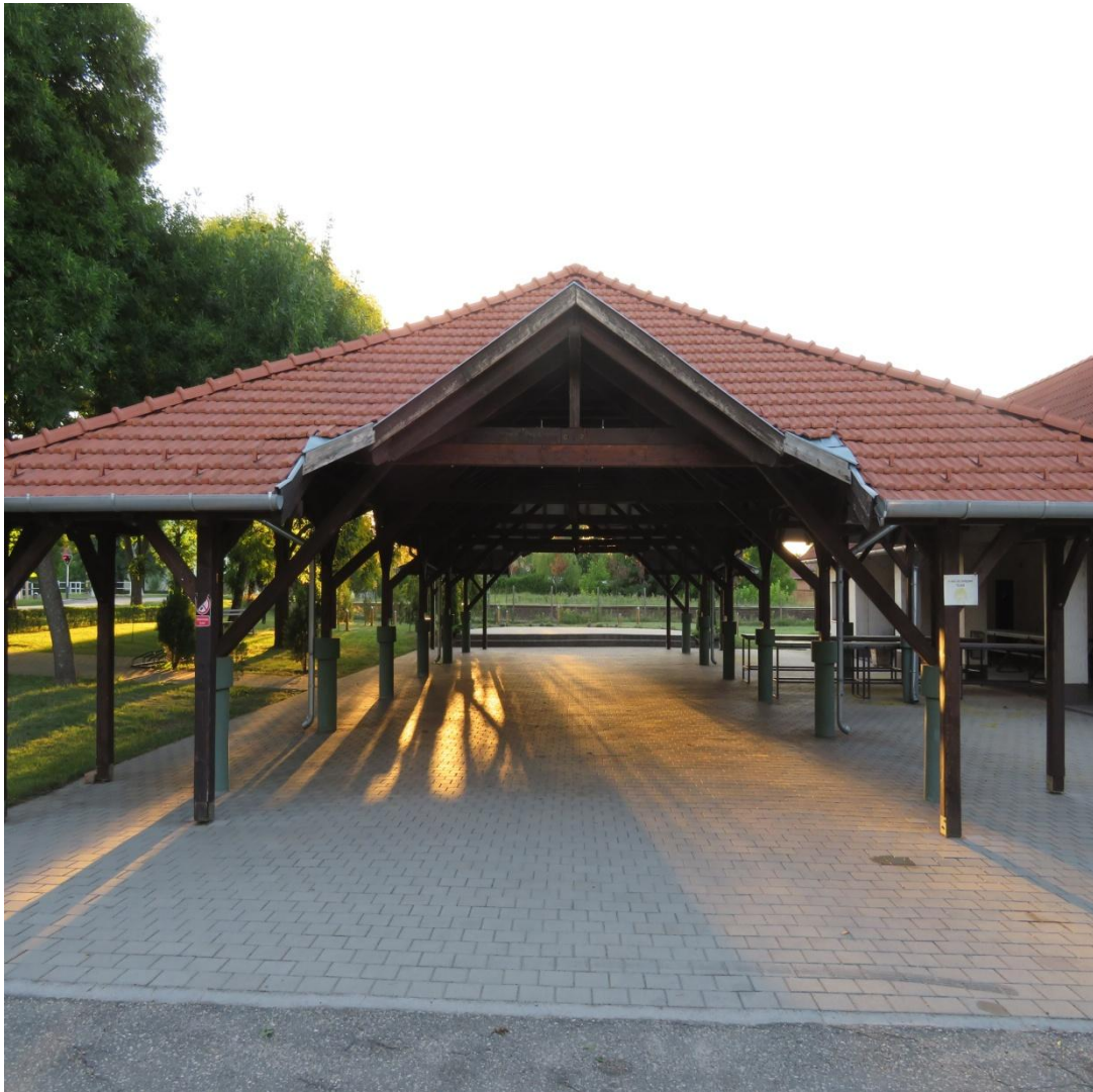
A Piac-csarnok véghomlokzata, nézet a vasúti sínek felé.
