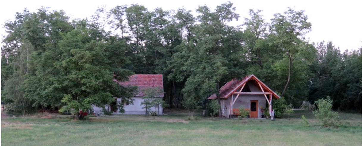
A meglévő régi épületek felújításával kialakított üdülőtanya, Kalmárföld
