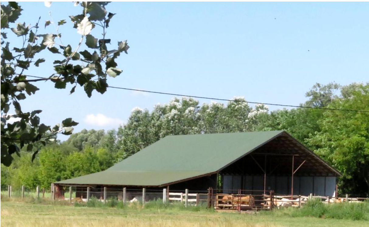
Hízómarha tartás színépülete, precíz acélszerkezettel, a tájba illeszkedés egyik lehetősége a zöld színű tetőhéjazat alkalmazása.
