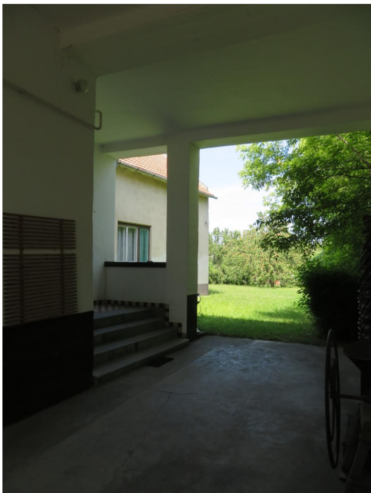
A kapualj, a belső épületszárny (Rákóczi utca 20., közösségi Ház)
