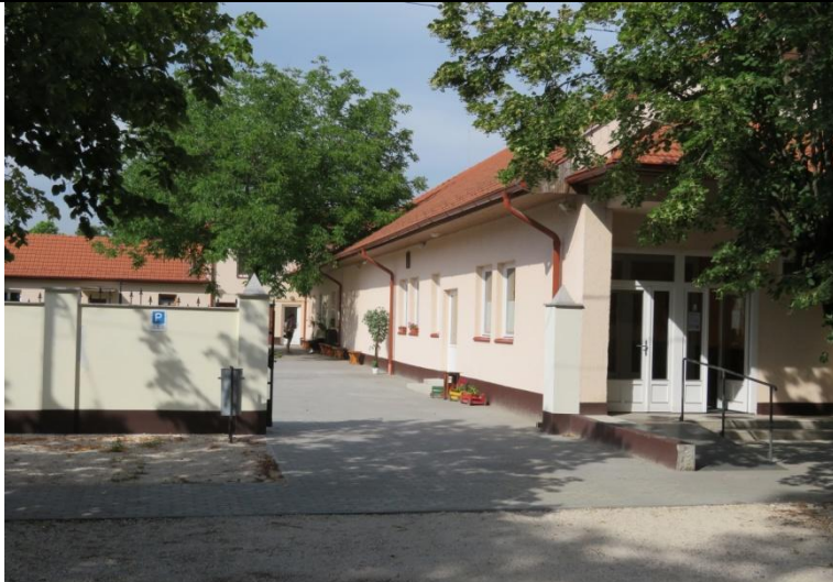
A Vasút utcai bejárat, 2017 júliusi állapot
