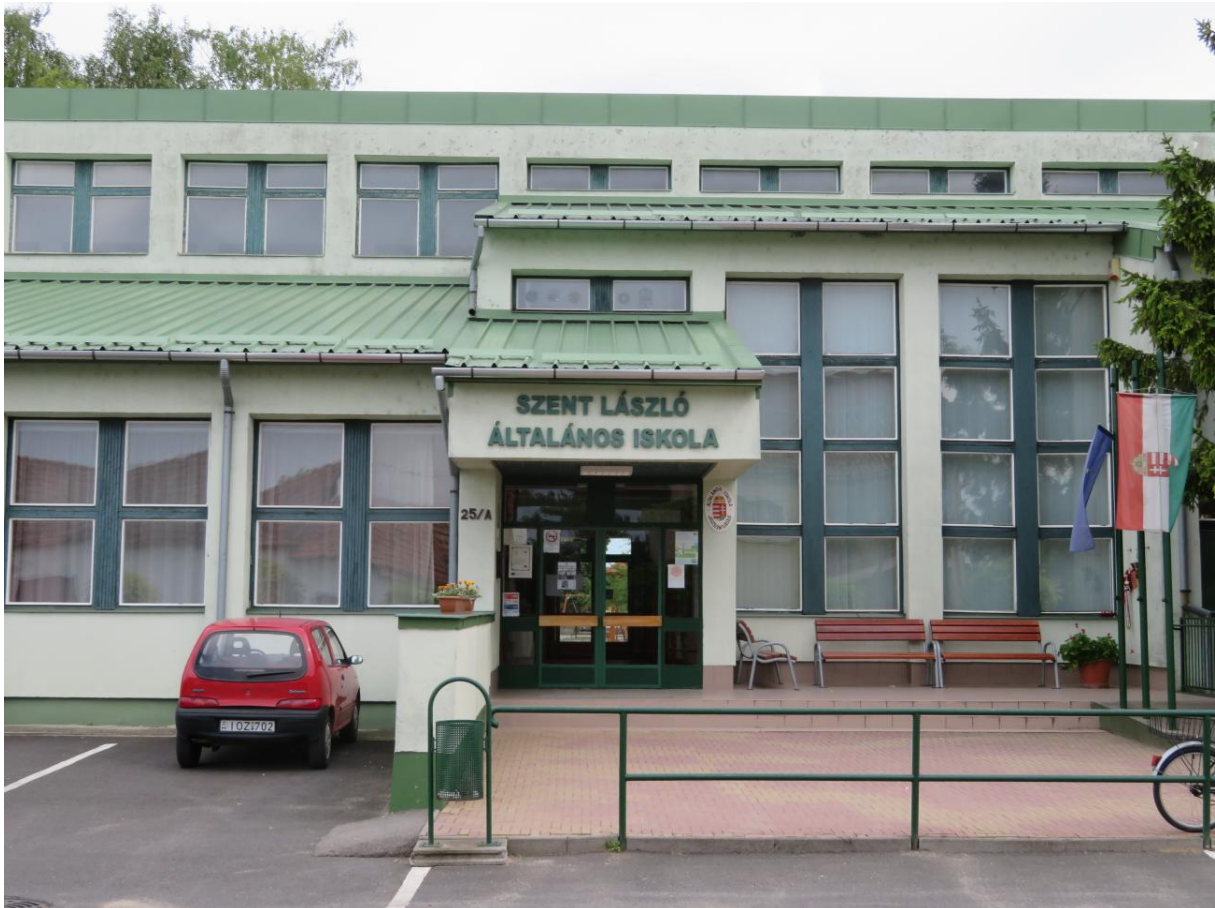
Főbejárati homlokzat a Rákóczi utca felől
