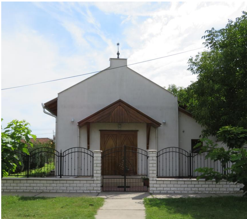
Református templom Rákóczi utcai homlokzata
