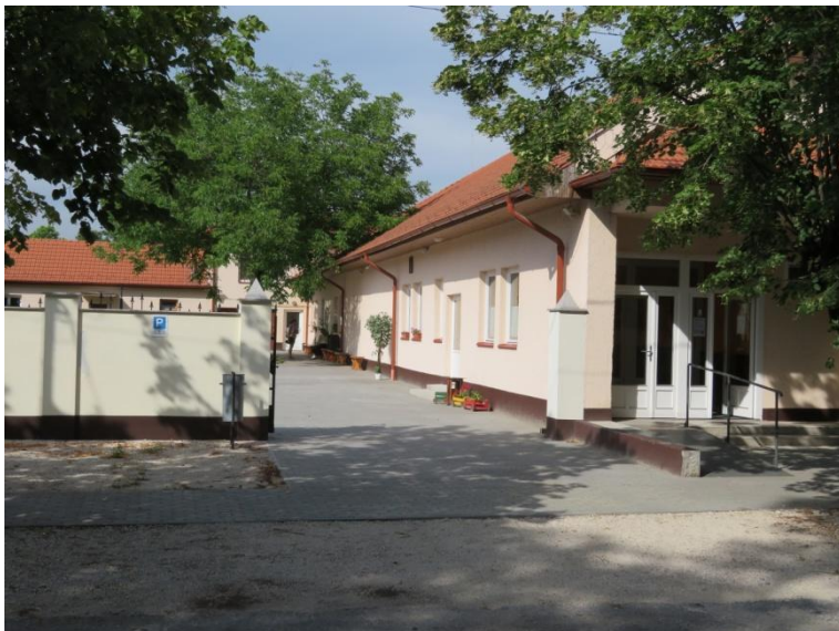
Vasút utcai bejárati homlokzat
